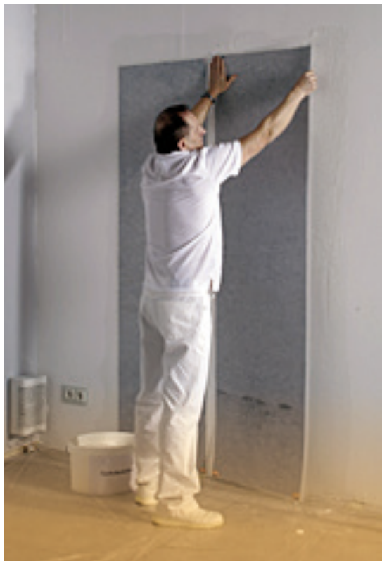
Oben: Wärmebildaufnahme 24V-IR Heizfolie Links: Verarbeitung wie eine Tapete
